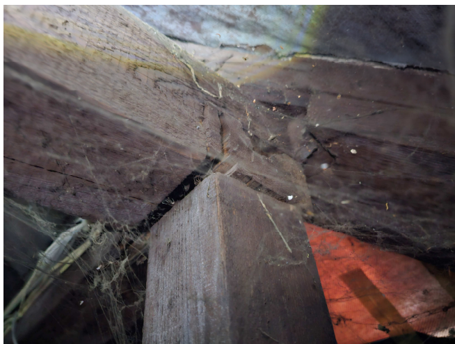
Zdj. 2: Połączenie platew-krokiew narożna.
