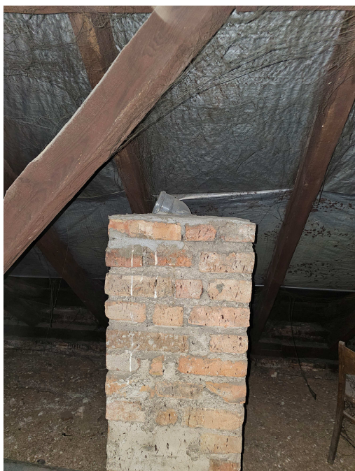
Zdj. 11: Brak ciągłości wentylacji grawitacyjnej.
