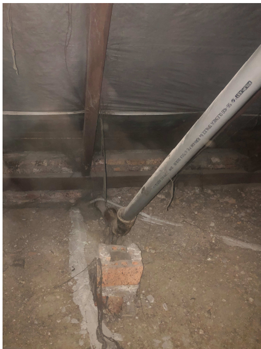
Zdj. 9: Wyprowadzenie wentylacji grawitacyjnej ponad połac dachową.
