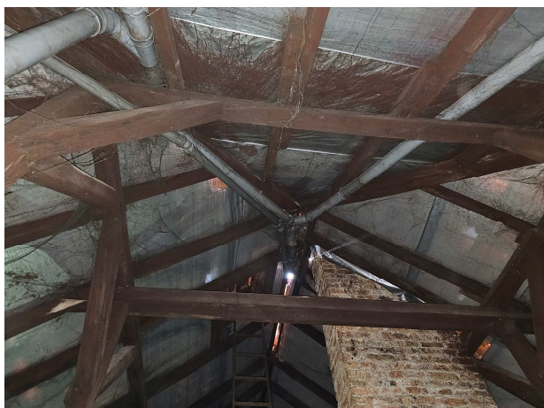
Zdj. 13: Wyprowadzenie wentylacji grawitacyjnej ponad powierzchnię połaci dachowej.
