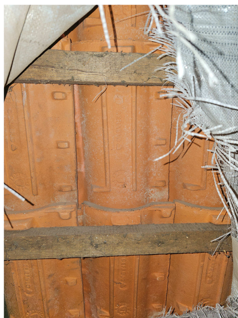
Zdj. 15: Brak ciągłości paroizolacji, stan łąt dachowych.
