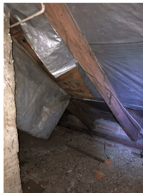
Zdj. 14: Brak ciągłości paroizolacji.
