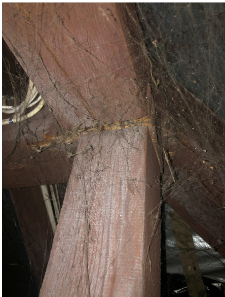
Zdj. 1: Połączenie platew-krokiew narożna.
