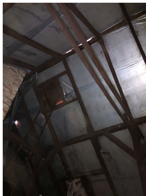
Zdj. 16: Prześwity pokrycia widoczne w kalenicy.
