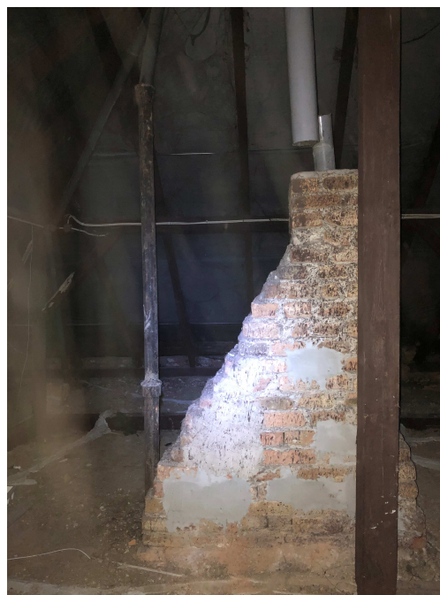
Zdj. 10: Wyprowadzenie wentylacji grawitacyjnej ponad połac dachową.
