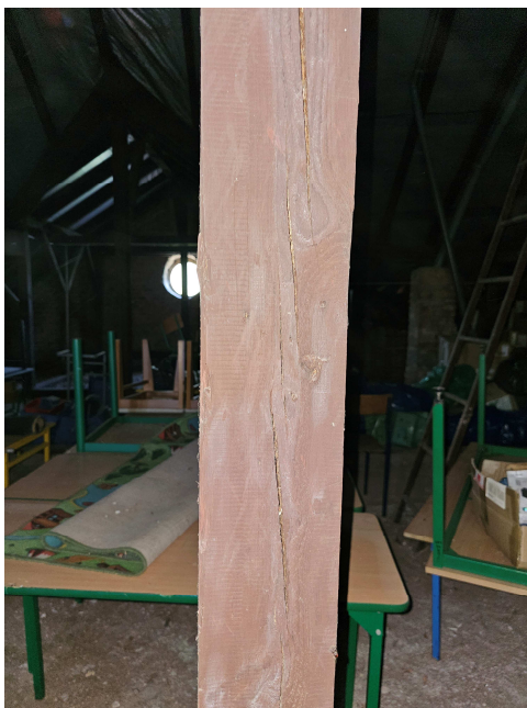
Zdj. 3: Pęknięcia na słupie.
