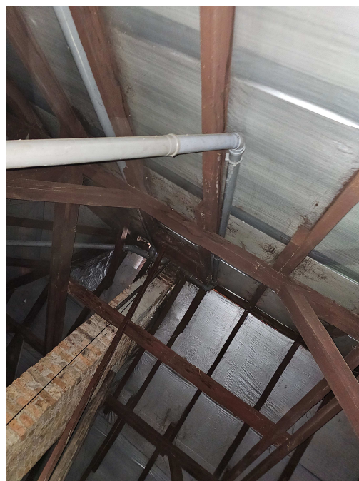
Zdj. 12: Wyprowadzenie wentylacji grawitacyjnej ponad połac dachową.
