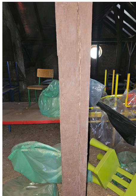
Zdj. 4: Pęknięcia na słupie.
