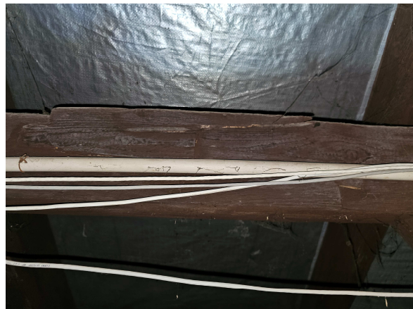
Zdj. 6: Pęknięcia na płatwi.
