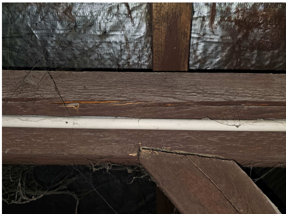
Zdj. 5: Pęknięcia na płatwi.
